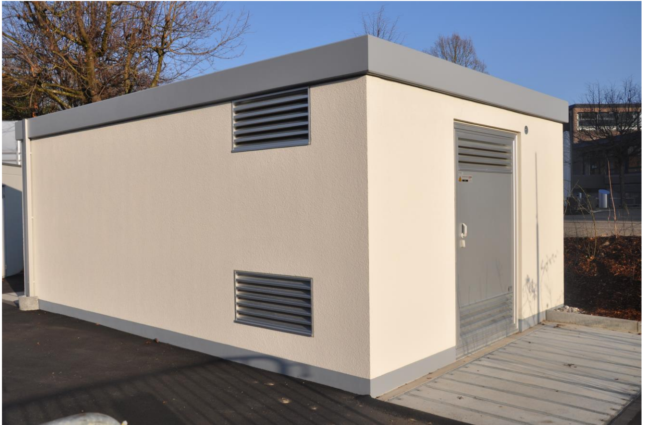
Die neue Trafostation BZZ.
