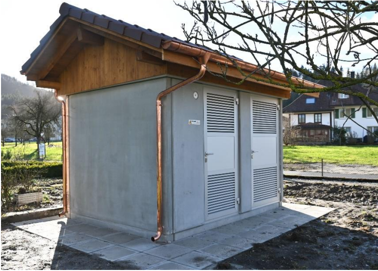
Bildlegende: Die neugebaute Trafostation an der Brittnauerstrasse 45 in Strengelbach.
