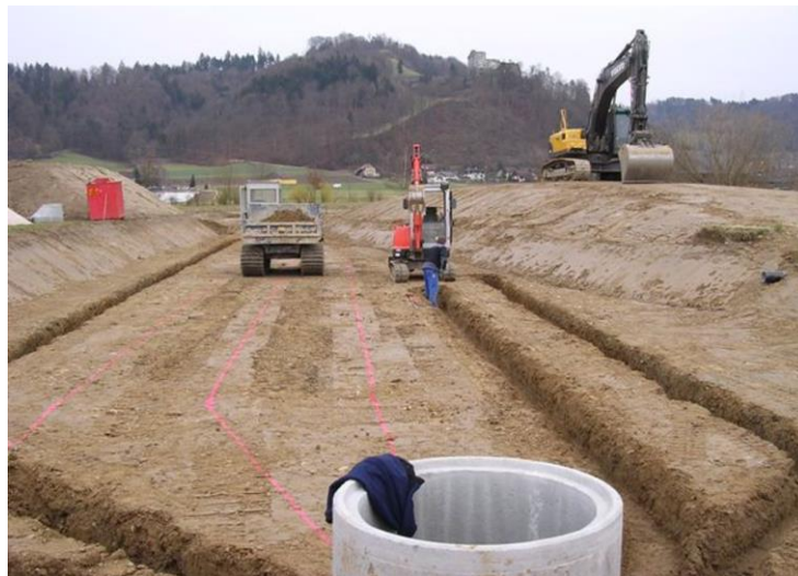
Baustelle Versickerungsanlage Höchmatt
