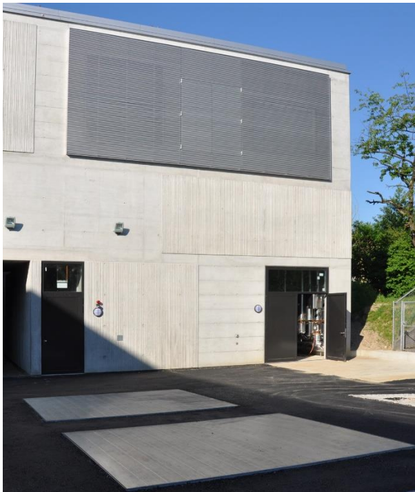
Bildlegende: Der Neubau der Energiezentrale Spital mit Holzsnitzelfeuerung und Notstromanlage.
