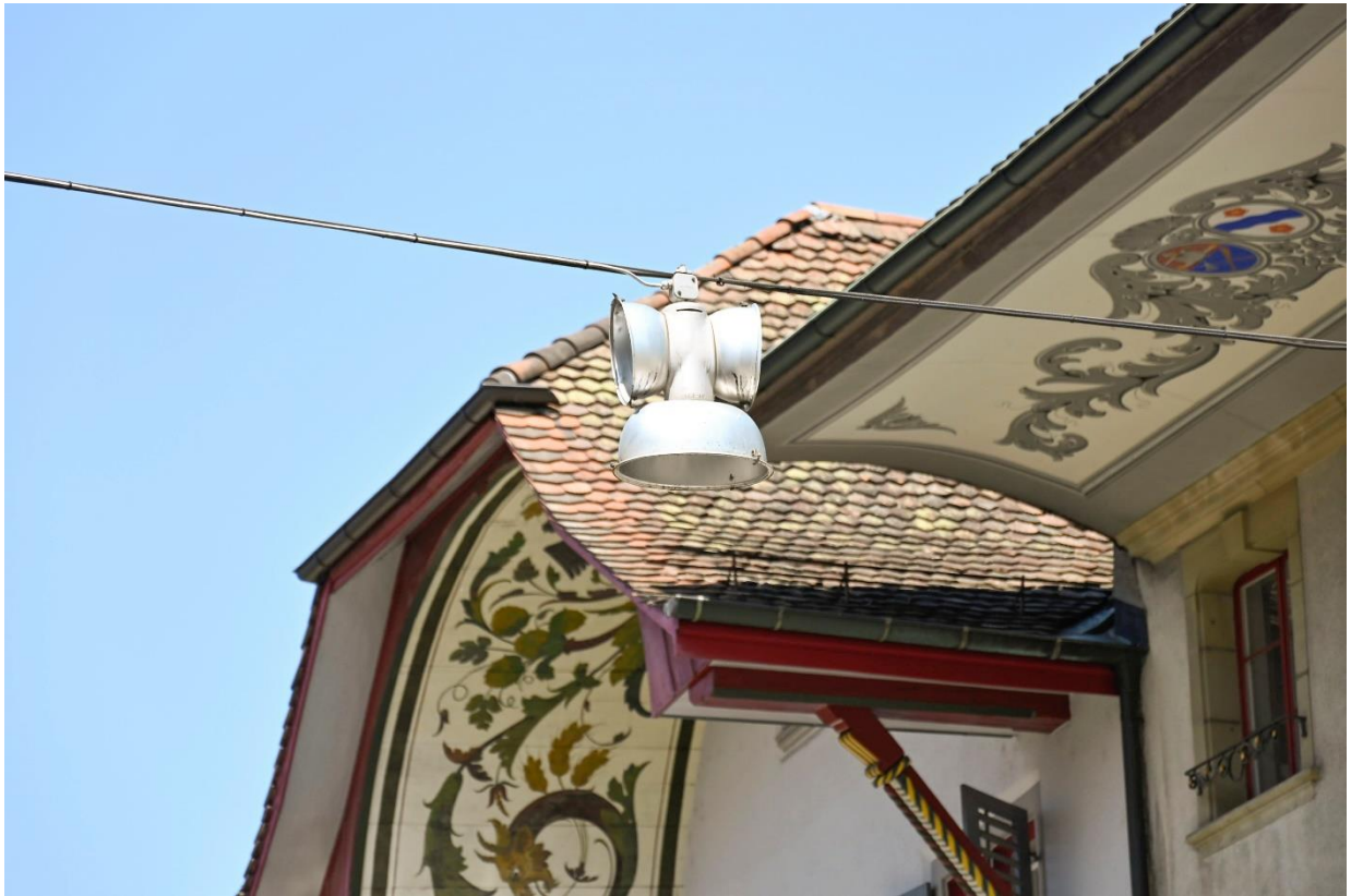
Bildlegende: Die alten Seilpendelleuchten in der Zofinger Altstadt werden durch neue LED-Leuchten ersetzt.
