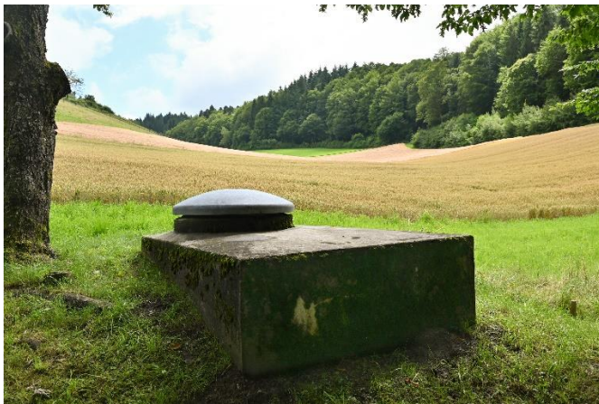
Bildlegende: Wird ersetzt: Die Sammelbrunnstube beim Quellwasserpumpwerk Mühlethal mit Baujahr 1965.
