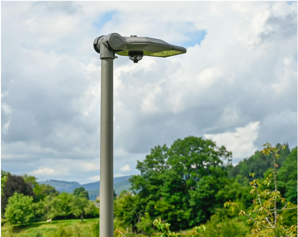
Bildlegende: Am Alten Kirchweg Ost wird die Strassenbeleuchtung auf LED umgerüstet.
