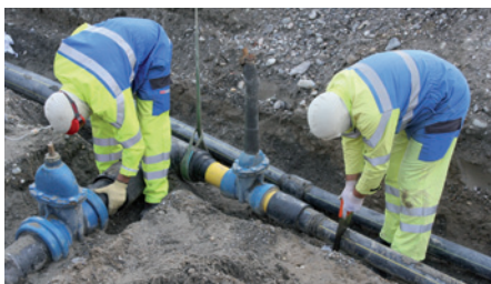
Roland Weber (l.) und Urs Läubli bei den Leitungsarbeiten.
