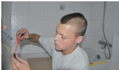
Der Lernende Kevin Schmid bei der Installation eines Lichtschalters
