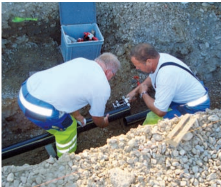
Marcel Müller (links) und Rolf Kammermann bereiten eine Muffenschweissung vor.
