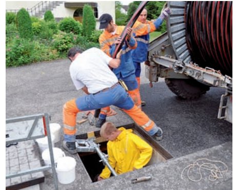
Elektronetzmitarbeiter beim Einziehen der Kabel
