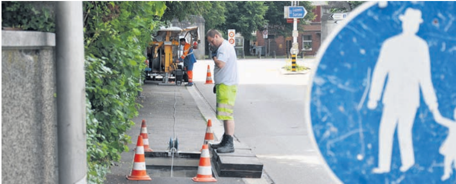
Baustelle Luzernerstrasse mit Absperungen
