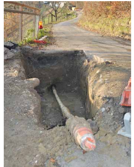
Bild oben: Endgraben mit Leitungseinzugskopf
