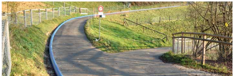
Bild unten: Die 100 m lange Leitung bereit zum Einzug
